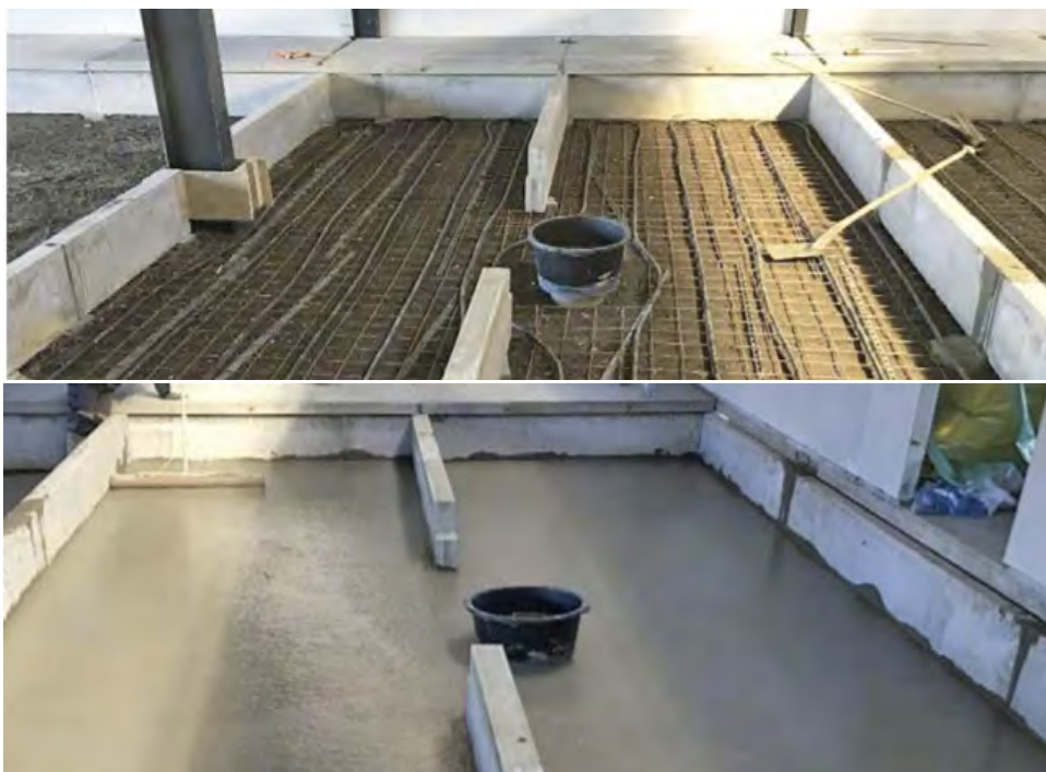
Obr. 6: Instalace chladicího systému do podlahy podroštových prostorů a její finalizace
