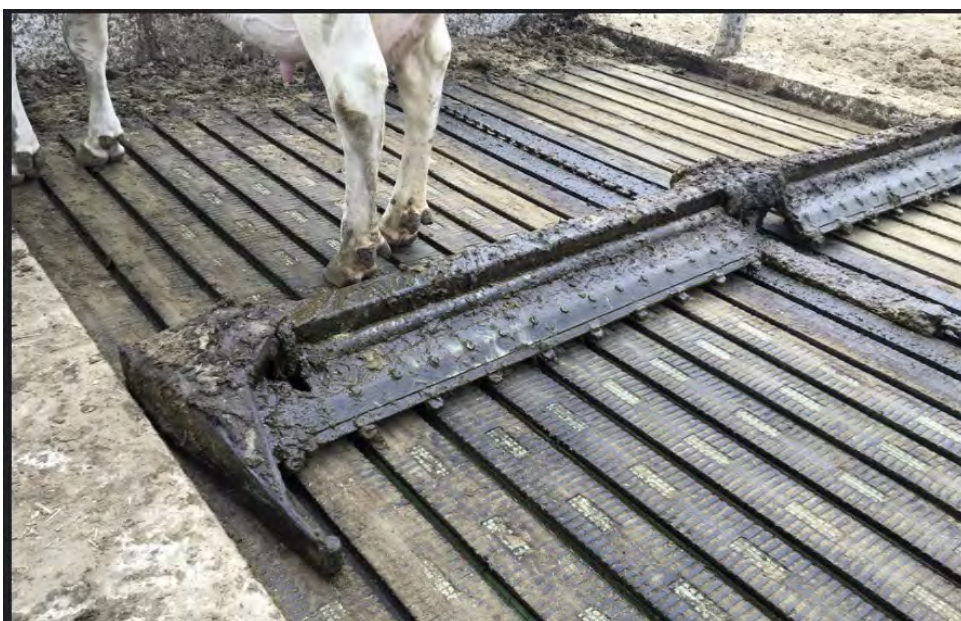
Obr. 4: Drážkovaná podlaha s otvory pro odvod moči
