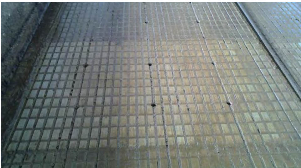
Obr. 4: Drážkovaná podlaha s otvory pro odvod moči
