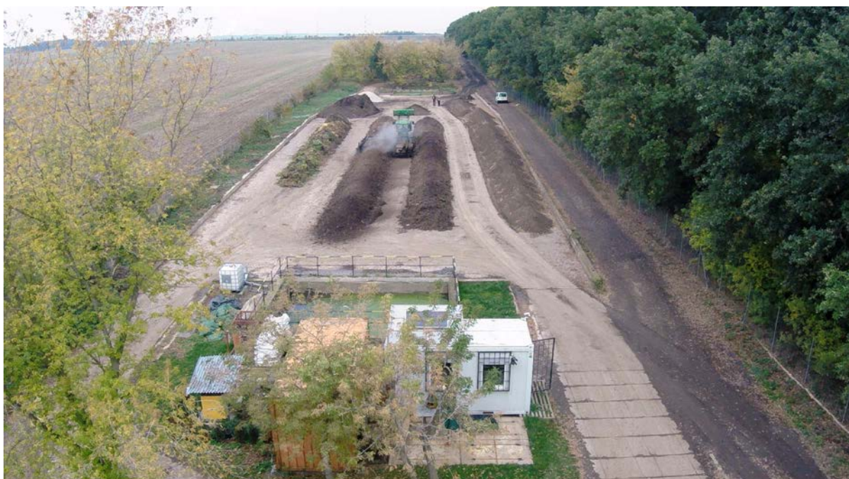
Obr. 26 Kompostárna ECOWOOD Unhošť provozovaná na bývalém polním hnojišti
