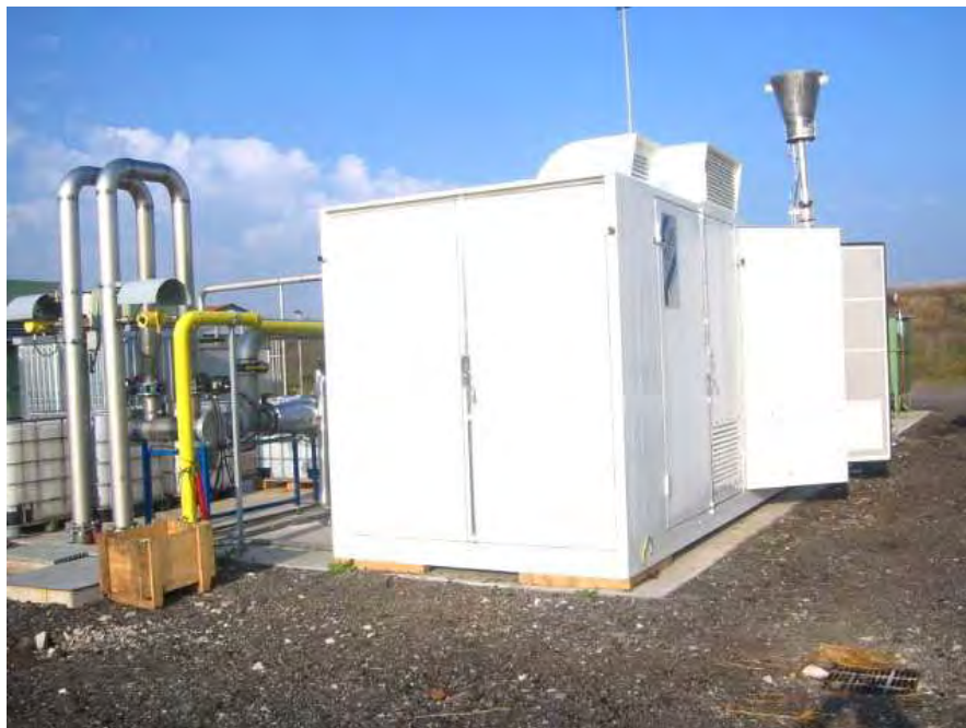
Zařízení na úpravu bioplynu v kontejnerovém provedení Equipment for biogas treatment in container version
