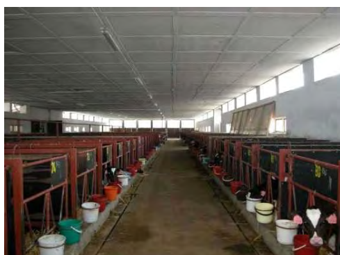
Obr. 4 Rekonstruovaný zateplený teletník Fig. 4 Reconstructed calfhousing with thermal insulation
