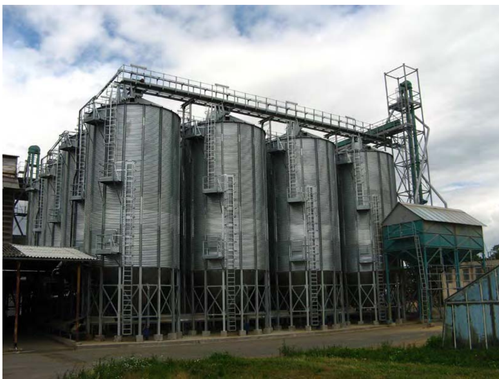
Obr. 2 Posklizňová linka pro ošetřování a skladování zrnin 12x 1000 tun ZOD Potěhy Fig. 2 Post-harvest line for treatment and storage of grains 12x 1000 tons ZOD Potěhy
