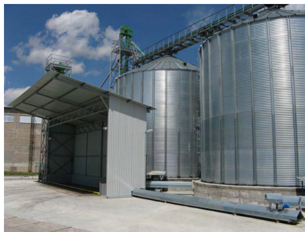
Obr. 3 Příjmový zásobník a věžové zásobníky DINA v ZAS Podchotucí, a.s., Křinec
