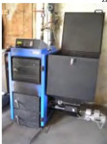
Obr. 6 Pohled na automatický teplovodní kotel AM 24 Licotherm na zkušebním okruhu
