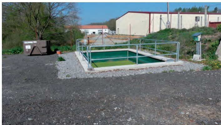
Železobetonová záhybná jímka se skladovací kapacitou 60 m 3 je umístěna vedle kompostovací plochy pod úrovní povrchu, kolem jímky je zábradlí, součástí jímky je čerpadlo pro zavlažovací systém
