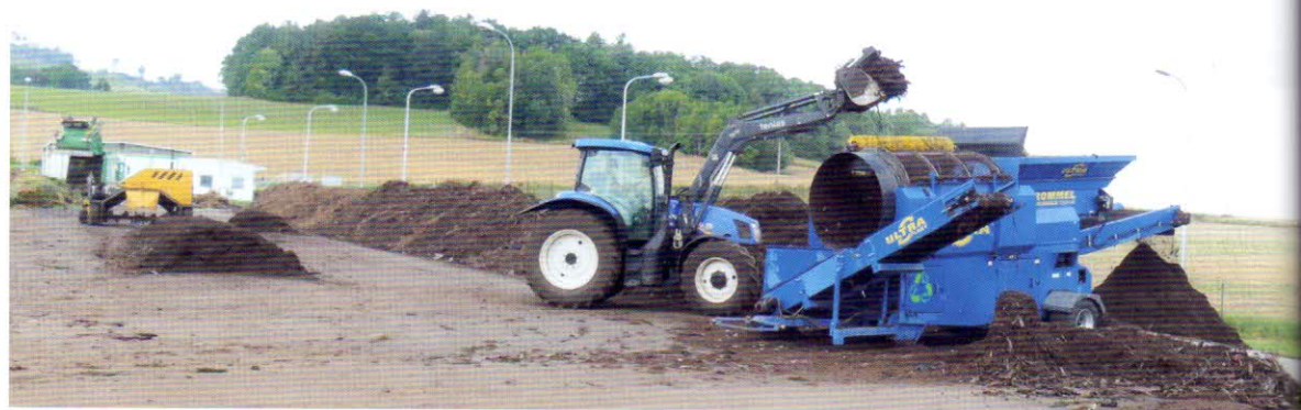
Kompostovací plocha s betonovým povrchem a celkovou výměrou 3090 m 2 (113 x 30 m), z toho je 2300 m 2 plochy vodohospodářsky zabezpečeno; plocha je vyspádována a vody jsou z povrchu plochy svedeny otevřenými kanálky do záchytné jímky
