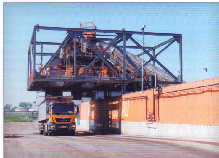
Michací zařízení se zásobníky a výpustí
