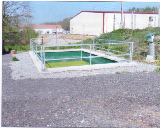
Železobetonová záchytná jímka se skladovací kapacitou 60 m 3 je umístěna vedle kompostovací plochy pod úroveň povrchu, kolem jímky je zábradlí, součástí jímky je čerpadlo pro zavlažovací systém
