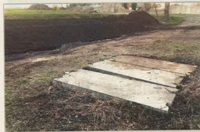
Záchytná jímka železobetonové konstrukce (objem záchytné jímky 18 m 3 ) je umístěna v bezprostřední blízkosti kompostovací plochy pod úrovní povrchu, je opatřena betonovým víkem Foto Petr Plíva
