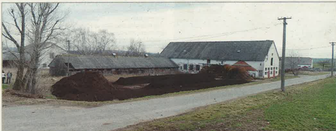
Od října 2014 je v provozu kompostárna ProFarm Blatnice. Pro zpracování biologicky rozložitelných odpadů je využívána technologie kompostování v pásových hromadách na volné ploše
