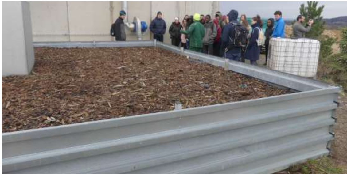
Obr. 3: Biofiltr zařazený do systému z důvodu zamezení úniků zápašných plynů
