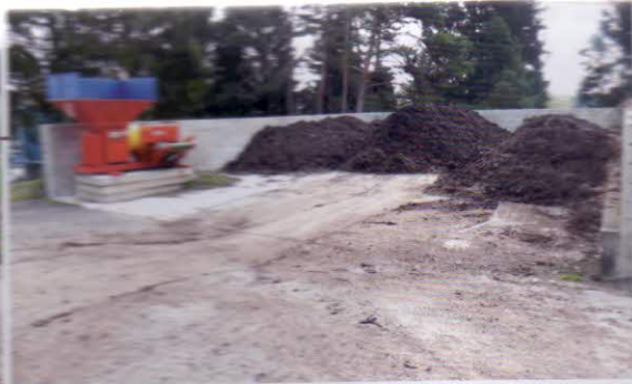
Plochy kompostárny – zpevněná plocha pro příjem BIO (176 m 2 ), zpevněná plocha pro dozrávání kompostu (294 m 2 ), nezabezpečená kompostovací plocha pro umístění naplněných vaků (900 m 2 )
