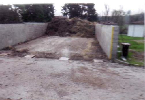
Plochy kompostárny – zpevněná plocha pro příjem BIO (176 m 2 ), zpevněná plocha pro dozrávání kompostu (294 m 2 ), nezabezpečená kompostovací plocha pro umístění naplněných vaků (900 m 2 )
