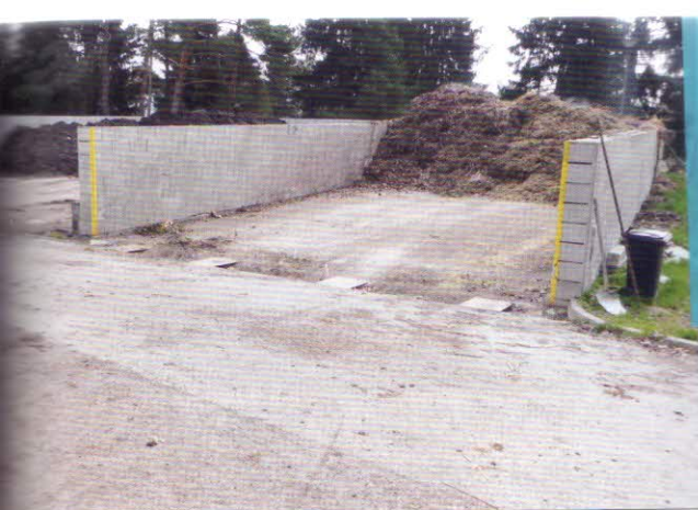
Žlab č. 1 pro uskladnění surovin ke zpracování (vpravo), žlab č. 2 pro dozrávání kompostu (vlevo)
