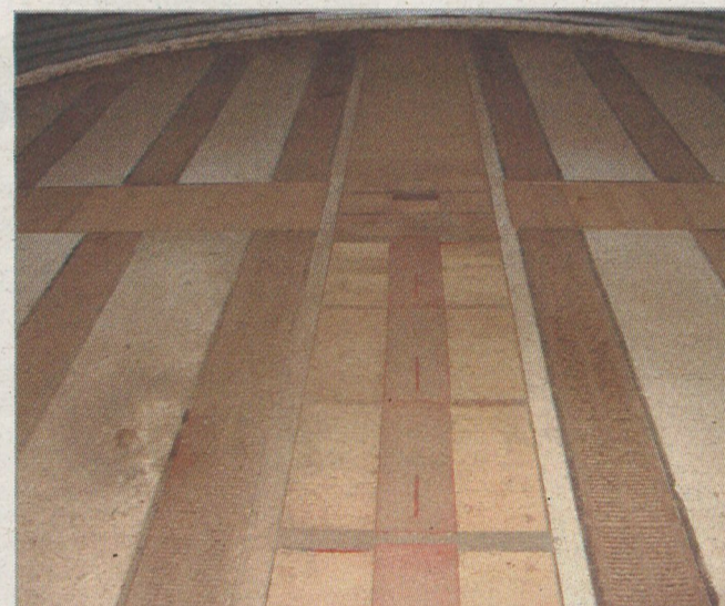
Pohled na dno věžového zásobníku, detail provzdušňovacích kanálů a vyskladňovací šachty
