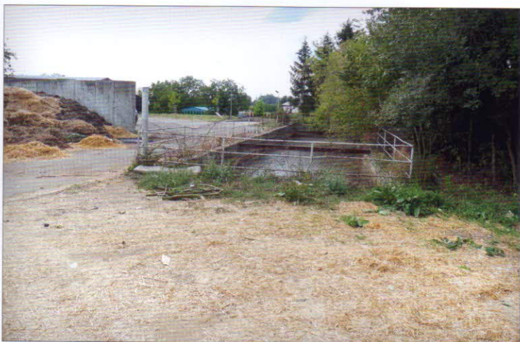
Otevřená zachytná jímka je umístěna v bezprostřední blízkosti kompostovací plochy pod úrovní povrchu – hloubka pod okolním terémem 3,6 m – objem zachytné jímky 523 m 3 – skladovací kapacita jímky 404 m 3
