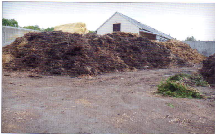
Kompostovací plocha – vodohospodářsky zajištěná betonová plocha se svodem do zachytné jímky. Po třech stranách plochy jsou betonové mantinely, vysoké zhruba 3 m. Rozměry jsou 29 x 45 m, velikost plochy 1300 m 2
