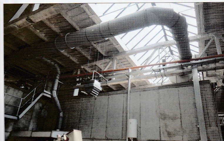
Zajištění aerace zpracovávaných surovin – provzdušňování vzduchotechnickým systémem a překopávání založených surovin
