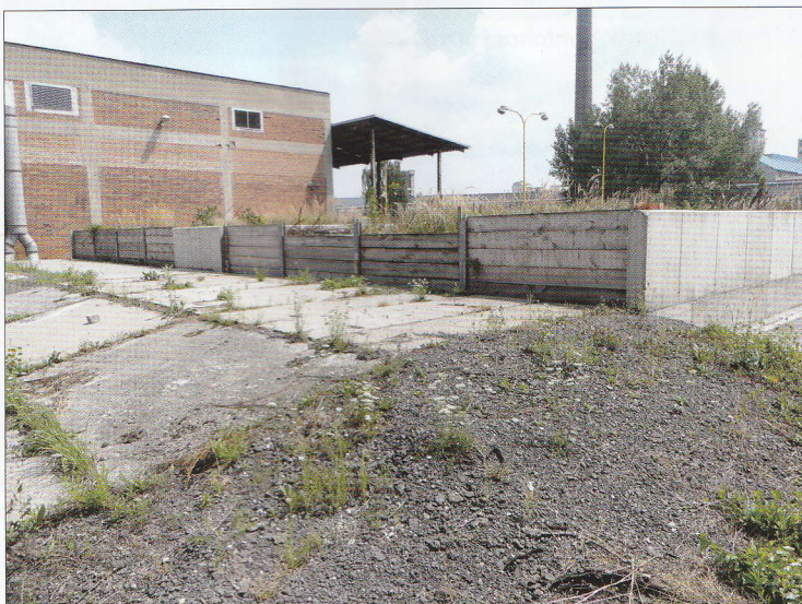
Součástí vzduchotechnického systému je biofiltr
