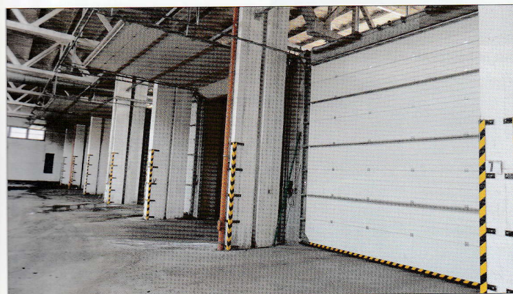
Řízená termofilní aerobní fermentace – soustava sedmi fermentačních boxů (půdorysný rozměr fermentační boxu 30,5 x 5,6 m, konstrukční výška boxu 5 m, výška zavážená surovinami 2 m, pracovní objem fermentačního boxu 340 až 680 m 3 )
