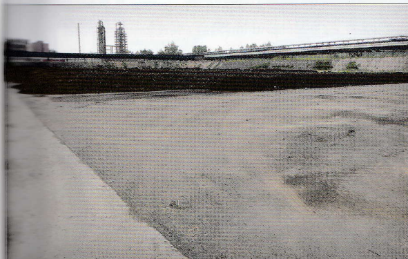
Kompostovací volná venkovní plocha - 1. část plochy (20 000 m 2 ) je vodohospodářsky zabezpečena (asfaltobetonový povrch); 2. část plochy (19 000 m 2 ) je zpevněná (asfaltorecyklátový povrch)
