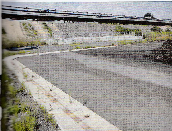
Zadržování vod z kompostovací plochy - záchytné jímky. Dešťové vody a výluhové štávy z dozrávajících kompostů (dále vody) z kompostovacích ploch jsou zachycené v obvodovém žlábků a jsou svedeny do tří záchytných jímek, které jsou umístěné bezprostředně vedle kompostovacích ploch. Skladovací kapacita jímek 1660 m 3
