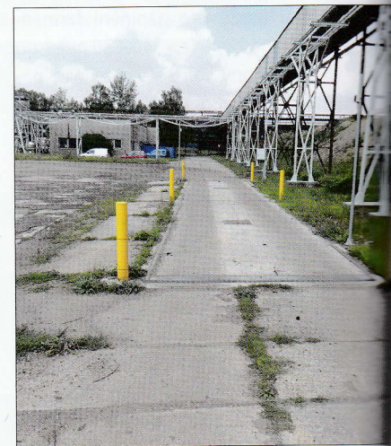
Evidenční příjmaných surovin – silniční mostní nájezdová váha s váživostí 60 000 kg
