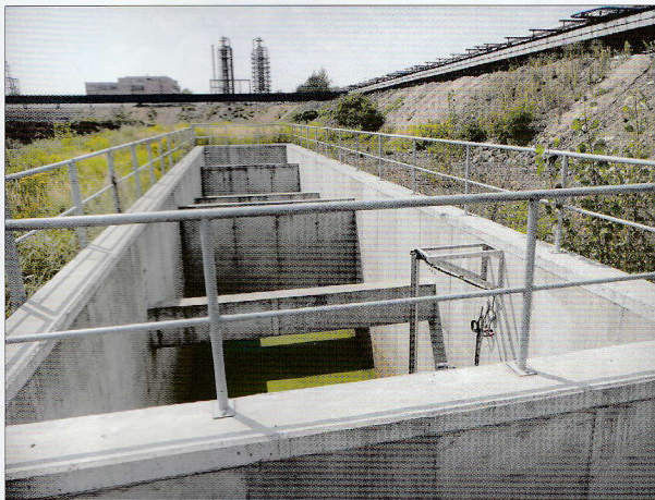
Zadržování vod z kompostovací plochy - záchytné jímky. Dešťové vody a výluhové štávy z dozrávajících kompostů (dále vody) z kompostovacích ploch jsou zachycené v obvodovém žlábků a jsou svedeny do tří záchytných jímek, které jsou umístěné bezprostředně vedle kompostovacích ploch. Skladovací kapacita jímek 1660 m 3
