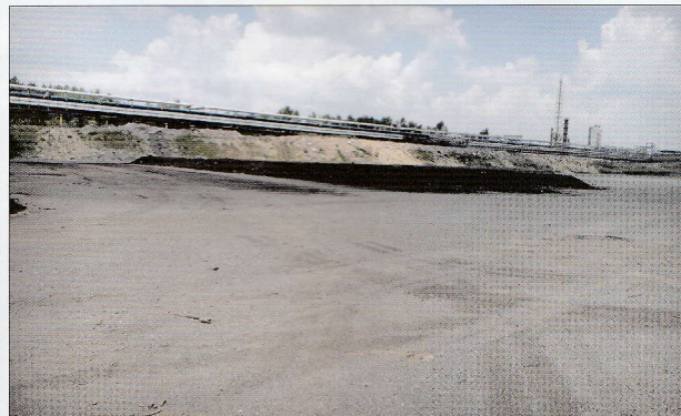
Kompostovací volná venkovní plocha - 1. část plochy (20 000 m 2 ) je vodohospodářsky zabezpečena (asfaltobetonový povrch); 2. část plochy (19 000 m 2 ) je zpevněná (asfaltorecyklátový povrch)
