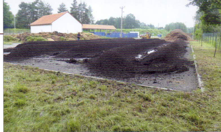
Kompostovací plocha – venkovní plocha je vodohospodářsky zabezpečená s asfaltobetonovým povrchem (celková výměra plochy 957 m 2 ). Plocha je vybavena po obvodu obrubníkem, je vyspádovaná a voda je svedena do záchytné jímky
