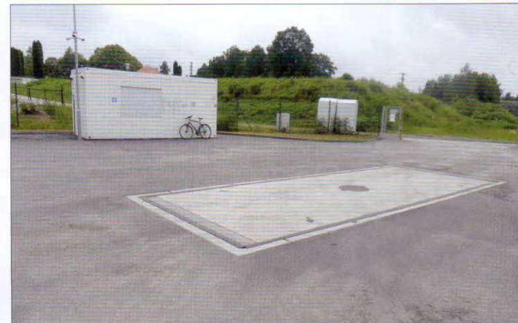
Evidence přijímaných surovin – silniční nájezdová ocelovo-betonová váha Tamtron Scalex 1001 s váživostí max. 40 000 kg
