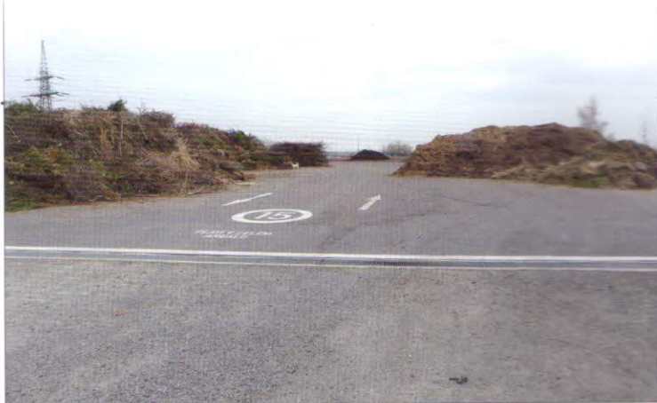
Venkovní kompostovací plocha je vodohospodářsky zabezpečená s asfaltobetonovým povrchem; celková výměra plochy 4678 m 2
