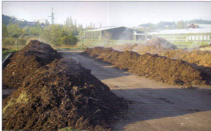
Venkovní kompostovací plocha je vodohospodářsky zabezpečená, konstrukce – asfaltobetonový povrch, obal. kamenivo mechanicky zpevněné, šterkodrt, obrubníky 15 cm, nepropustnost zajištěna hydroizolační fólií VFPE, vyspádovaná. Celková výměra plochy 1600 m 2 . Odvod kapalin z plochy spádováním do záchytné jímky – objem jímky 76,5 m 3
