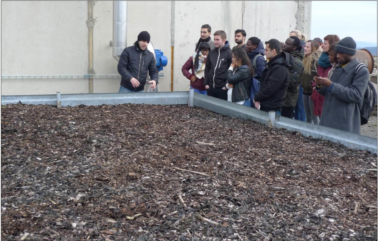
Obr. 4: Biofiltr zařazený do systému z důvodu zamezení úniků zápašných plynů
