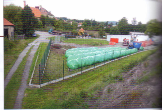
Kompostovací plocha venkovní – trojúhelníkový půdorys, zpevněná, z asfaltového betonu, opatřená izolační vrstvou proti průsakům do podloží, je spádována do odvodňovacího žlabu zaústěného do bezodtokové záchytné jímky. Celková výměra plochy 675 m 2 , objem záchytné jímky 40 m 3
