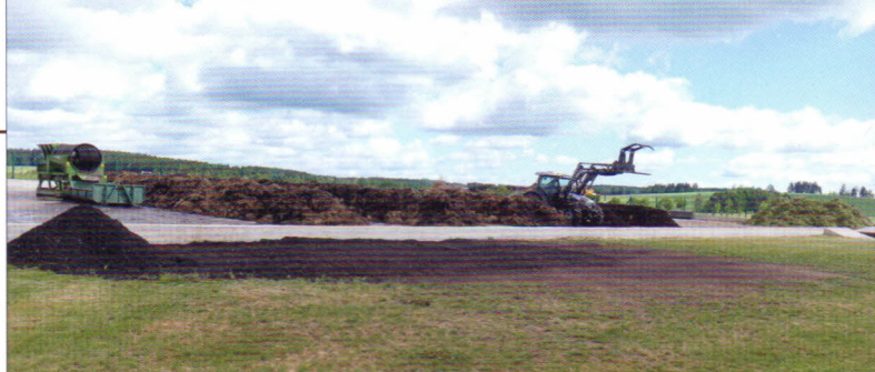
Venkovní kompostovací plocha je vodohospodářsky zabezpečená, s betonovým povrchem; celková výměra plochy 2800 m 2 ; rozměry plochy 70 x 40 m. Plocha je vybavena po obvodu sběrným kanálkem svedeným do záchytné jímky a je vyspádovaná – 1%
