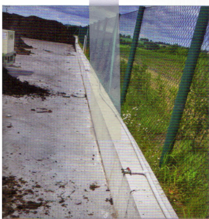
System rozvodu zachycené vody z jímky
