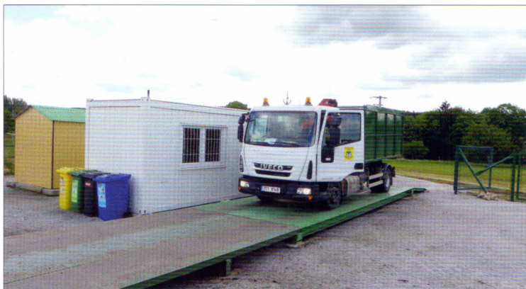
Evidence přijímaných surovin – silniční mostní nájezdová váha Váhy-Jas PROFI-UNIVERZAL ocelové konstrukce; rozměry vážící plošiny 3 x 8 m, váživost do 30 000 kg s přesností ±10 kg
