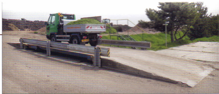
Evidence přijímaných surovin – silniční mostní váha MEN Příbram typ RODAN s betonovým nájezdem (váha je nad úrovní vozovky). Váživost do 30 000 kg, přesnost ±10 kg
