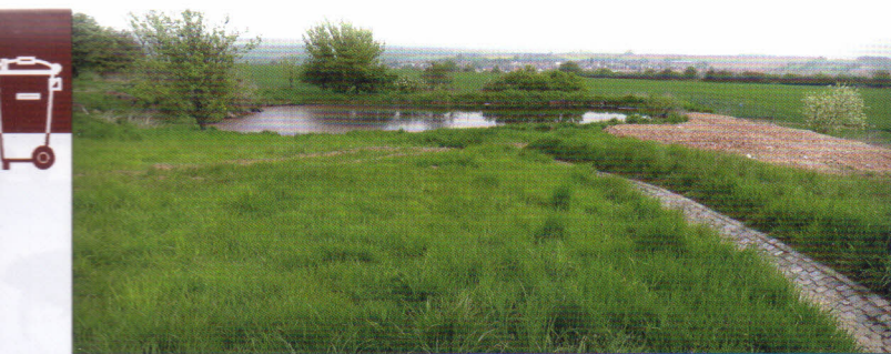
Záchytná jímka je řešena jako otevřená nádrž kruhového tvaru, která je umístěna nedaleko kompostovací plochy pod její úrovní. Kapacita jímky 400 m 3 , nádrž je zajištěna nepropustným jílovým těsněním
