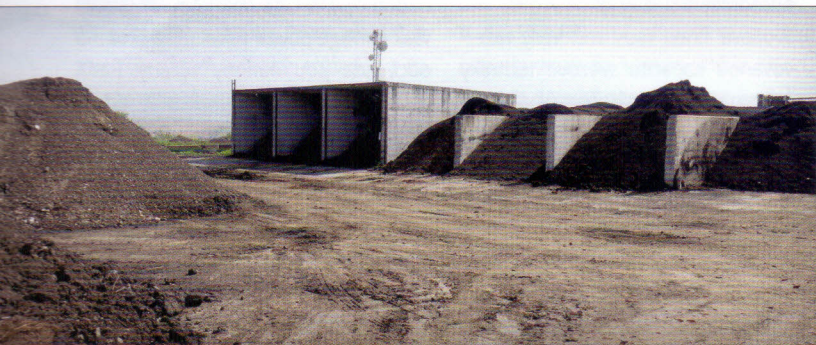
Uskladnění vyrobeného kompostu – uskladňovací železobetonové boxy. Tři uzavřené boxy s celkovou úložnou kapacitou 3 x 112,66 m 3 za rok a tři polootevřené boxy s celkovou úložnou kapacitou 3 x 70,82 m 3
