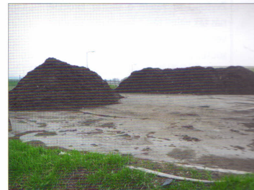
Venkovní kompostovací plocha je vodohospodářsky zabezpečená s asfaltobetonovým povrchem; celková výměra plochy 1680 m 2 , tj. 21 x 80 m, plocha je příčně vyspádovaná
