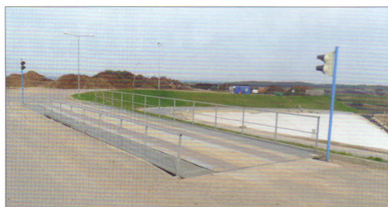
Evidence přijímaných surovin – silniční mostní váha RODAN s vážovostí do 60 000 kg a přesností ± 10 kg
