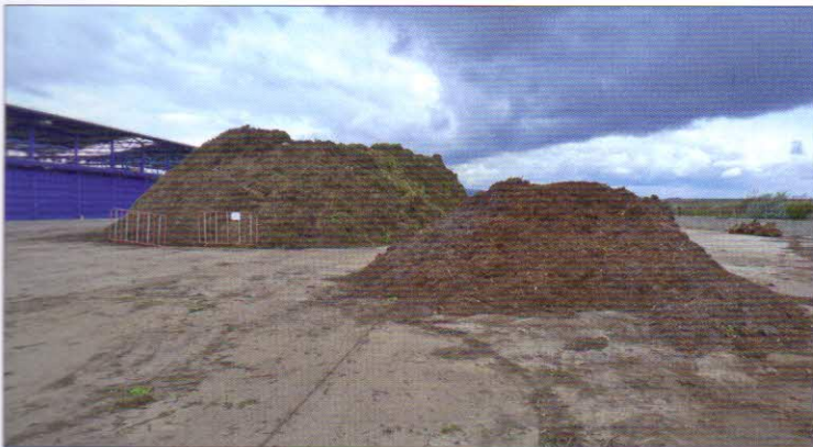
Obr. 2 – Zpevněná, vodohospodářsky zabezpečená plocha pro přípravu a uskladnění zpracovávaných surovin
