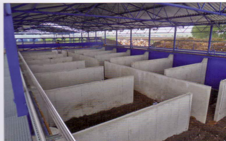
Obr. 9 – Kompostovací komory - zrcadlové uspořádání
