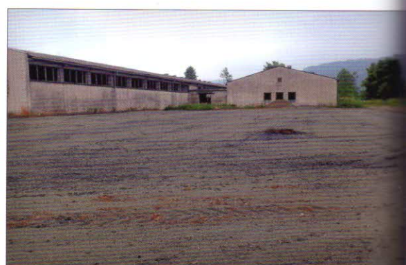
Venkovní kompostovací plocha je vodohospodářsky zabezpečena šterková plocha s asfaltovým postřikem; celková výměra 1250 m 2 ; plocha je vyspádovaná a podzemní kanalizací jsou vody z povrchu svedeny do záchytné jímky
