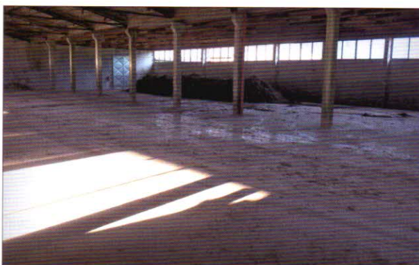
Vnitřní kompostovací plocha je vodohospodářsky zabezpečena s betonovým povrchem; celková výměra – 1280 m 2 . Plocha je vyspádovaná a podzemní kanalizací jsou vody z povrchu plochy svedeny do záchytné jímky mimo objekt; skladovací kapacita jímky je 30 m 3
