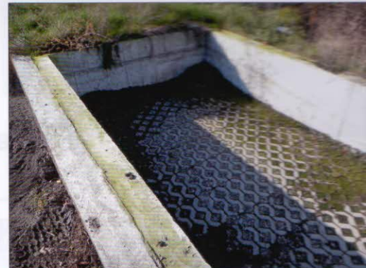
Propustné dno kalové nádrže
