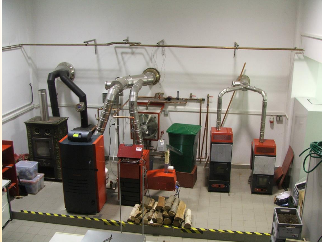
Laboratoř pro zkoušení kotlů na tuhá biopaliva
