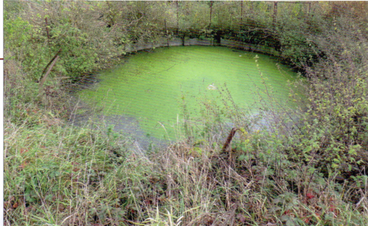
Záchytná jímka železobetonové konstrukce se skladovací kapacitou 125 m 3 je umístěna vedle kompostovací plochy pod úrovní povrchu
