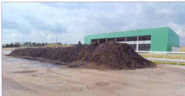
Kompostovací plocha je vodo hospodářsky zabezpečena s asfaltobetonovým povrchem; celková výměra plochy je 1680 m 2 , tj. 21 x 80 m, plocha je příčně vypádovaná
