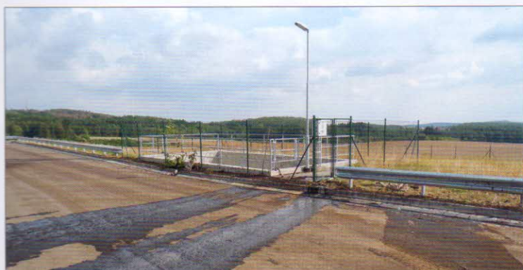
Záchytná jímka se skladovací kapacitou 100 m 3 je umístěna vedle kompostovací plochy pod úroveň povrchu. Konstrukce je železobetonová, jímka je vybavena ponorným kalovým čerpadlem s řezacím zařízením
