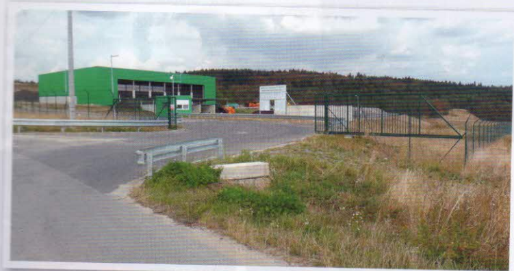
Oplocený areál Odpadového centra Petrůvky
