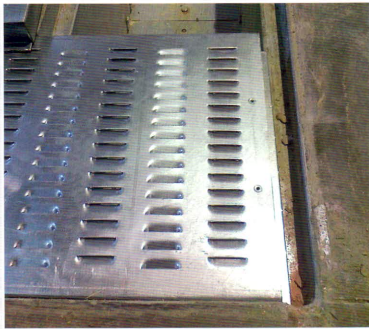
Podúrovňový provzdušňovací kanál s roštem
