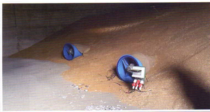
Halový sklad s teleskopickým nadúrovňovým provzdušňovacím systémem Foto Jiří Bradna
