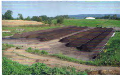
Kompostovací plocha – venkovní plocha je vodohospodářsky zabezpečená s asfaltovým povrchem; celková výměra plochy dosahuje 1700 m 2 . Plocha je vybavena po obvodu sběrným kanálkem svedeným do záchytné jímky a je vyspádovaná – 1%
