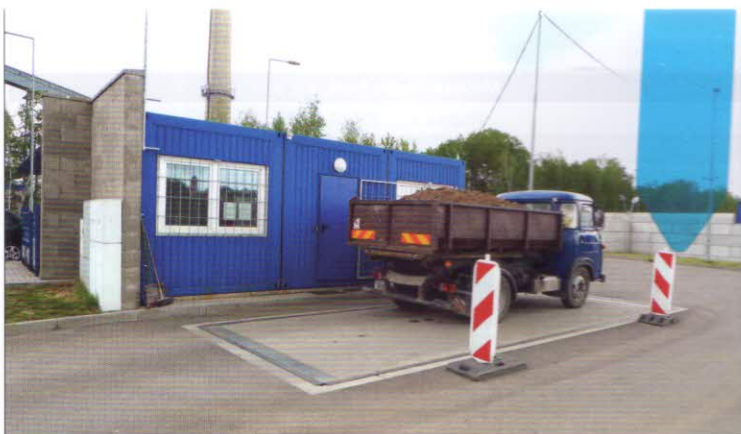
Evidence přijímaných surovin – silniční nájezdová váha ocelové konstrukce s váživostí do 30 000 kg s přesností ±10 kg
