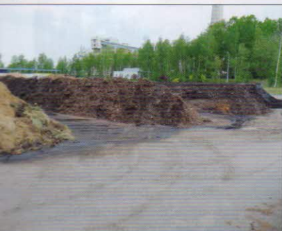
Kompostovací plocha venkovní je vodohospodářsky zabezpečená s asfaltovým povrchem; celková výměra plochy – 3604 m 2 , plocha je podélně vyspádovaná – 10 %, příčně vyspádovaná – 2 %
