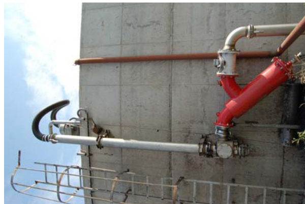
Obr. 7: Stávající způsob separace a současný stále se ucpávající filtr
