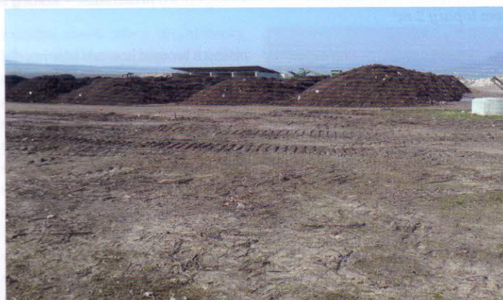
Venkovní kompostovací plocha je vodohospodářsky zabezpečena s asfaltovým povrchem, rozměry plochy 80 x 79 m, celková výměra plochy – 6 328 m 2 , plocha je podélně vyspádovaná – 3 %, na kraji plochy jsou umístěny vsaky do tělesa skládky
