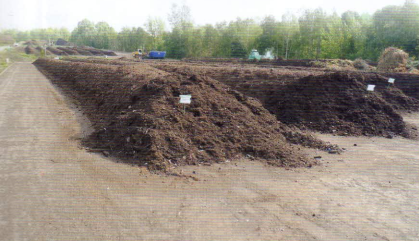
Kompostovací plocha (12 330 m 2 ) je složena celkem ze tří ploch, které jsou vodo hospodářsky zabezpečeny. Plochy jsou zpevněné asfaltovým povrchem, podélně vyspádované – 3 % a s příčným sklonem 1,5 % do středu. Kompostování probíhá na první a druhé kompostovací ploše, třetí slouží ke skladování štěpky, listů a hotových výrobků (kompost a substrát)
