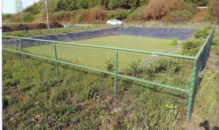
Záchytné jímky – znečištěná voda z vyspádovaných kompostovacích ploch je svedena do dvou záchytných jímek, objemy jímek – 165 m 3 a 369 m 3 . V případě potřeby je znečištěná voda ze záchytných jímek využívána při optimalizaci vlhkosti založených surovin nebo přečerpána do jímky skládkových vod
