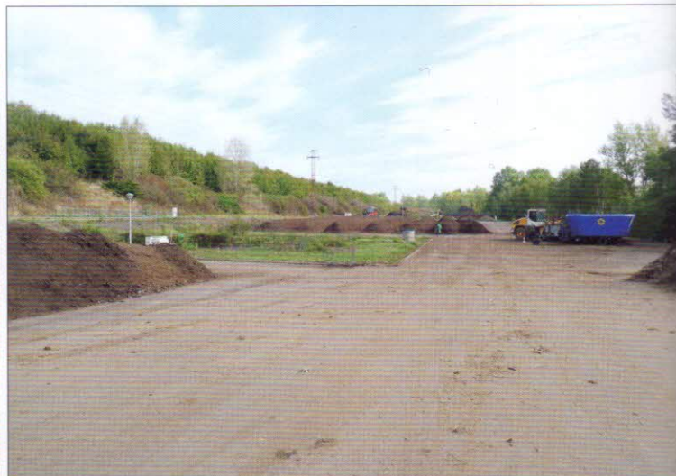
Kompostovací plocha (12 330 m 2 ) je složena celkem ze tří ploch, které jsou vodo hospodářsky zabezpečeny. Plochy jsou zpevněné asfaltovým povrchem, podélně vyspádované – 3 % a s příčným sklonem 1,5 % do středu. Kompostování probíhá na první a druhé kompostovací ploše, třetí slouží ke skladování štěpky, listů a hotových výrobků (kompost a substrát)
