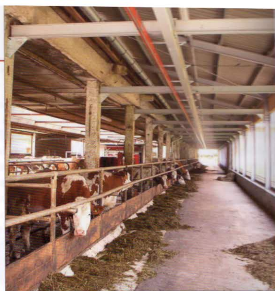
Ve stáji je instalována nosná konstrukce s pojezdovou kolejnicí. Krmný vozík Trioliet zakládá a současně přihruje zbytky krmiva podle programu řízeného počítačem
