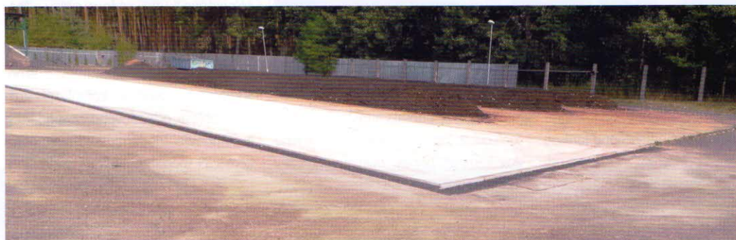
Kompostovací plocha - nově vybudovaná vodohospodářsky zajištěná asfaltobetonová plocha (703,00 m 2 ) se sběrným žlábkem po obvodě, se svodem do záchytné podzemní jímky. Rozměry 39,3 x 17,9 m
