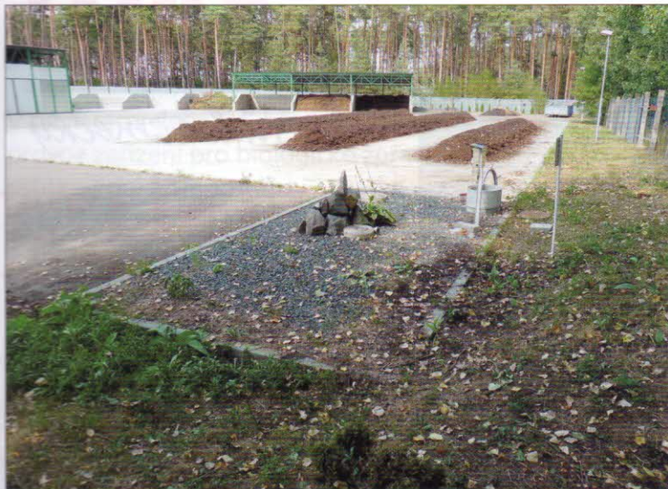
Podzemní jímka s celkovým objemem 36 m 3
