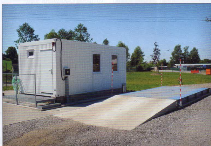
Evidence přijímaných surovin a expedovaného kompostu, administrativní buňka – silniční nápravová váha Gravex steel SH LP. Typ váhy – mostová silniční – 6 m s elektrickou přípojkou 380V, váživost do 30 t s přesností ± 5 kg
