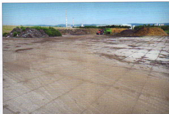
Technologie kompostování – kompostování na volné ploše. Překopávání zpracovávaných surovin v plošných hromadách kolovým nakladačem CAT 924H. Doba kompostování jeden až dva roky. Vodohospodářsky zajištěná plocha 11 800 m 2 má kapacitu 15 000 m 3 kompostu (objem jímky – 150 m 3 )
