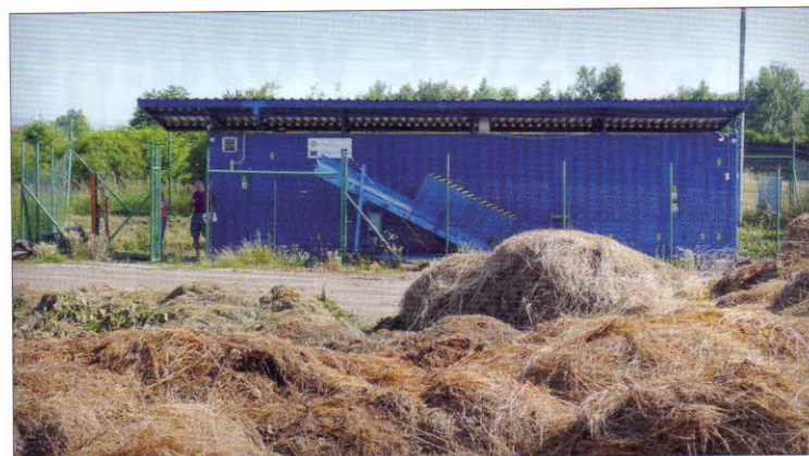
Technologie kompostování – aerobní fermentace v uzavřeném prostoru. Uzavřený fermentor EWA, model 2011 s objemem pracovního prostoru 36 m 3 . Doba zpracování 2–3 dny. Dozrávání kompostu na vodohospodářsky zajištěné ploše 8–12 týdnů
