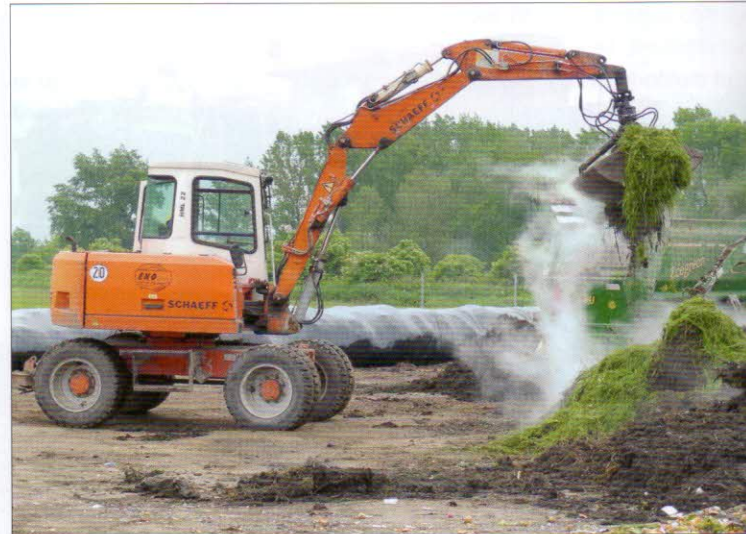
Manipulace se surovinami - rypadlo SCHAEFF HML 22 je vybavené drapákem
