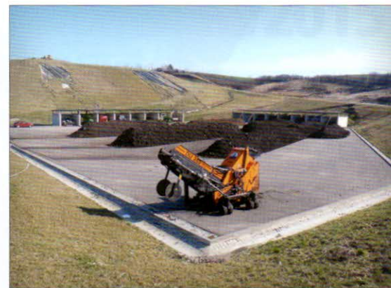
Kompostovací plocha - nově vybudovaná vodohospodářsky zajištěná asfaltová plocha se sběrným žlábkem po obvodu, se svodem do záchytné jímky. Kompostovací plocha má velikost 4 700 m 2 , objem jímky 200 m 3
