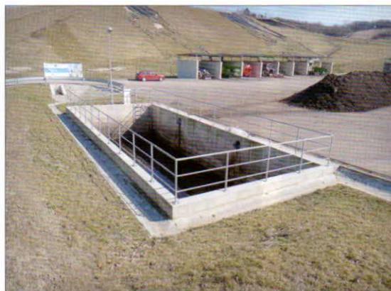
Kompostovací plocha - nově vybudovaná vodohospodářsky zajištěná asfaltová plocha se sběrným žlábkem po obvodu, se svodem do záchytné jímky. Kompostovací plocha má velikost 4 700 m 2 , objem jímky 200 m 3
