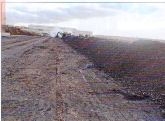
Kompostovací plocha – Compost Systems GmbH (Rakousko). Nově vybudovaná vodohospodářsky zajištěná betonová plocha, do které jsou zabudovány provzdušňovací kanály (COMPOair), se svodem do záchytné jímky. Kompostovací plocha – velikost 7400 m 2 , z toho 3200 m 2 provzdušňováno – (80 x 40) m, objem jímky – 384 m 3
