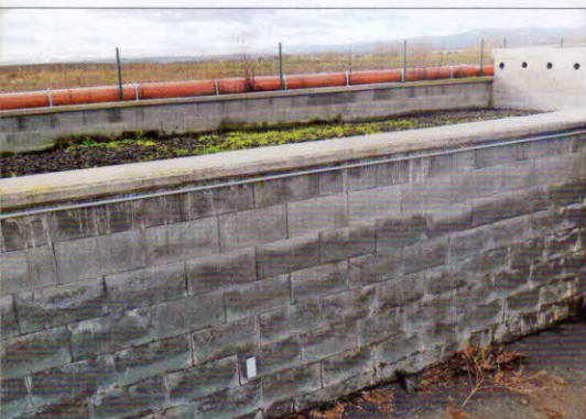
Vzduchový biofiltr Compost Systems GmbH (Rakousko) s objemem náplně 80 m 3 , druh náplně – kůra, různé frakce
