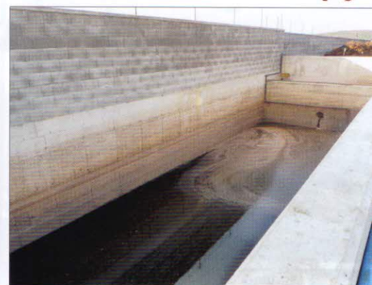
Kompostovací plocha – Compost Systems GmbH (Rakousko). Nově vybudovaná vodohospodářsky zajištěná betonová plocha, do které jsou zabudovány provzdušňovací kanály (COMPOair), se svodem do záchytné jímky. Kompostovací plocha – velikost 7400 m 2 , z toho 3200 m 2 provzdušňováno – (80 x 40) m, objem jímky – 384 m 3
