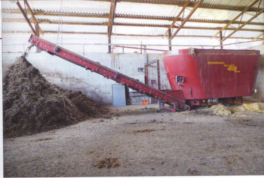
Úprava surovin před kompostováním – míchací zařízení vsádky B. STRAUTMAMMN & Söhne BIO – MIX Double 4000 s příkonem elektromotoru 2 x 32 kW a objemem pracovního prostoru 40 m 3
