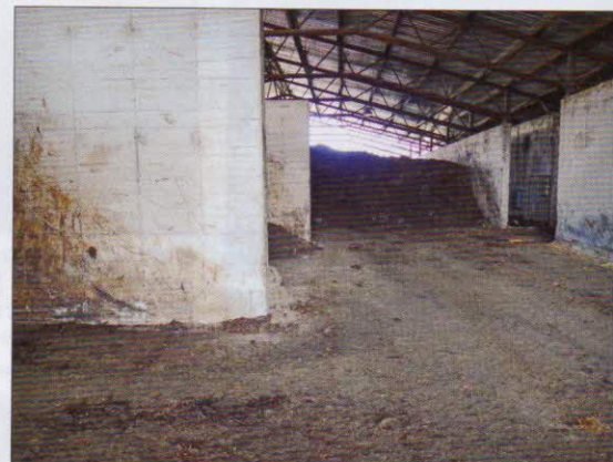
Dozrávání a skladování hotového kompostu – skladová hala s vodohospodářsky zajištěnou plochou. Počet uskladňovacích boxů – 5, velikost uskladňovacího boxu - 2 x 1500 t, 1 x 800 t, 2 x 600 t. Kapacita uskladňovaného množství je 5000 t
