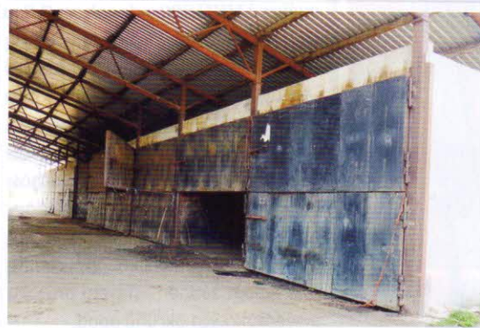
Technologie kompostování - soustava deseti fermentačních komor AGRONOM CS. Fermentační komora s půdorysem 5 x 7 x 4 m a objemem 140 m 3 (hmotnost vsázky asi 80 t)
