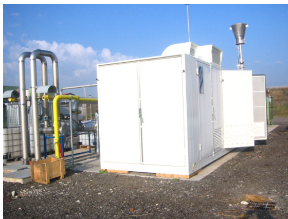
Obr. 21: Umístění kompresorové jednotky pro úpravu bioplynu v kontejneru na bioplynové stanici
