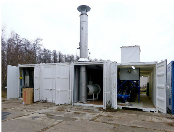
Obr. 9: Kontejnerové umístění vývojové a zkušební technologické linky VÚZT, v.v.i. Praha - PolyComp, a.s. Poděbrady pro karbonizaci a zplyňování zbytků a odpadů s výkonností 20 kg/h vstupní suroviny
