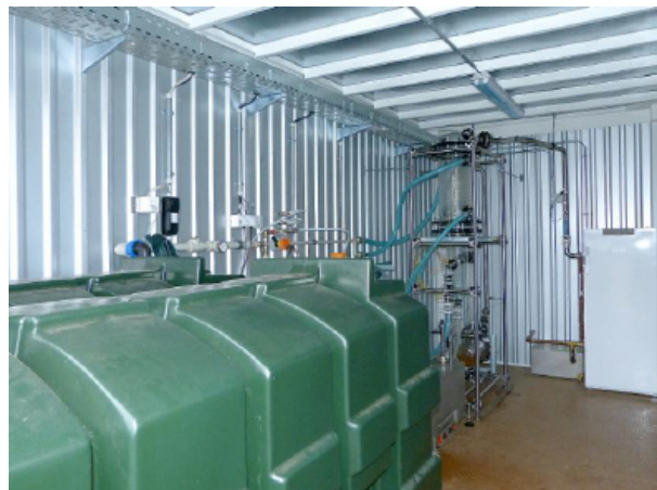
Obr. 10: Pohled na část provozního souboru chlazení a čištění syntézního plynu linky VÚZT, v.v.i. Praha - PolyComp, a.s. Poděbrady s nádržemi provozních kapalin a kondenzačních odpadů a prací kolonou surového syntézního plynu
