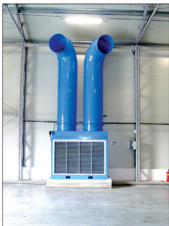
47 Příklad umístění integrované směšovací jednotky v paletovém skladu
