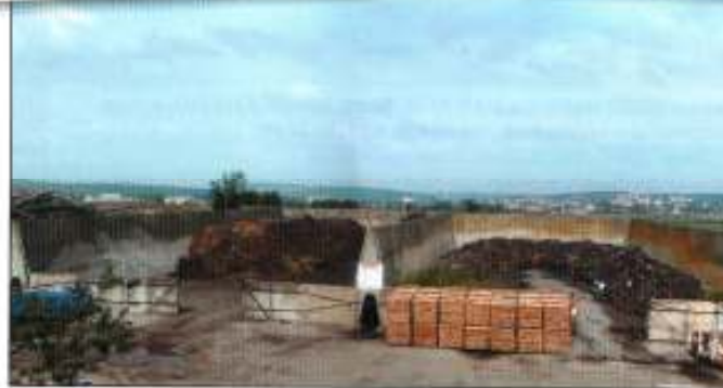
Kompostovací plocha je umístěna ve dvou silážních žlabech, je vodohospodářsky zajištěná. Plocha silážního žlabu č. I – 850 m 2 , plocha silážního žlabu č. II – 850 m 2 . Celková plocha kompostovacích ploch – 2500 m 2 , objem zachytivé jímky – 200 m 3
