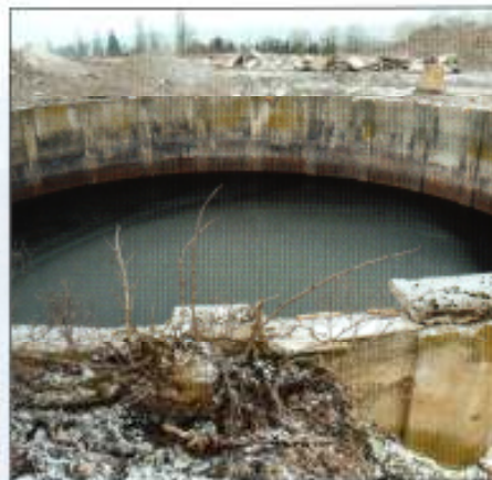
Kompostovací plocha – vodohospodářsky zajištěná asfaltová plocha se svodem do záchytné jímkky o velikosti: příjem materiálu – 1500 m 2 , kompostovadlní – 3500 m 2 , celková velikost – 5000 m 2 , objem jímkky – 1800 m 3
