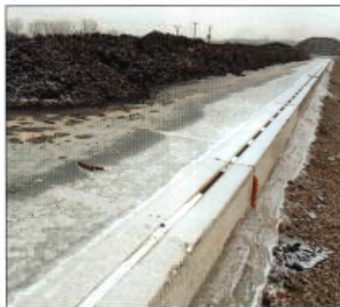
Kompostovací plocha – vodohospodářsky zajištěná asfaltová plocha se svodem do záchytné jímkky o velikosti: příjem materiálu – 1500 m 2 , kompostovadlní – 3500 m 2 , celková velikost – 5000 m 2 , objem jímkky – 1800 m 3
