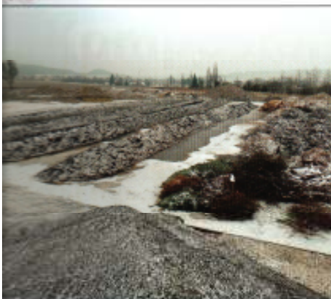
Kompostovací plocha – vodohospodářsky zajištěná asfaltová plocha se svodem do záchytné jímkky o velikosti: příjem materiálu – 1500 m 2 , kompostovadlní – 3500 m 2 , celková velikost – 5000 m 2 , objem jímkky – 1800 m 3
