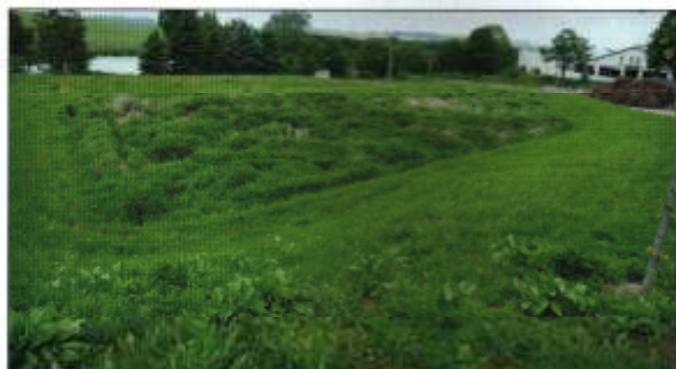
Sběrná jímka – z kompostovací plochy stéká voda do sběrné jímky, která je součástí systému rákosových polí. V rákosovém poli probíhá proces provzdušňování a zrání za pomoci kořenového systému rákosu. Objem jímky je 21,5 m 3 , kapacita rákosových polí bude osm až deset let
