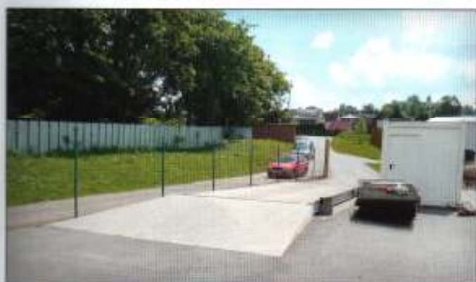
Evidenční přijímací surovin – silniční nápravová váha VM-1.2 s el. přípojkou 380V a váživostí do 20 000 kg s přesností ± 5 kg
