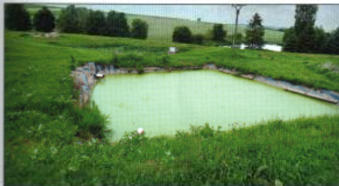
Sběrná jímka – z kompostovací plochy stéká voda do sběrné jímky, která je součástí systému rákosových polí. V rákosovém poli probíhá proces provzdušňování a zrání za pomoci kořenového systému rákosu. Objem jímky je 21,5 m 3 , kapacita rákosových polí bude osm až deset let
