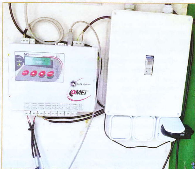
Pro monitoring byla použita měřicí a záznamová ústředna COMMET MS6D Foto Petr Plíva
